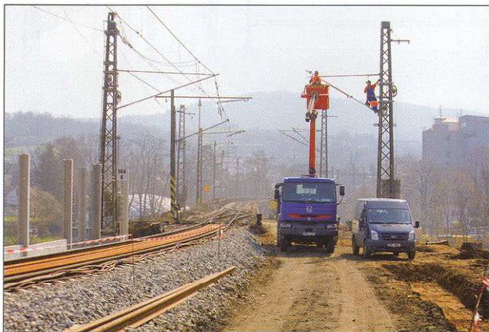
Na snímku jsou zachyceny snesená 1. TK a práce na zřizování nového trakčního vedení. Za vozidlem se nachází snesený most.
