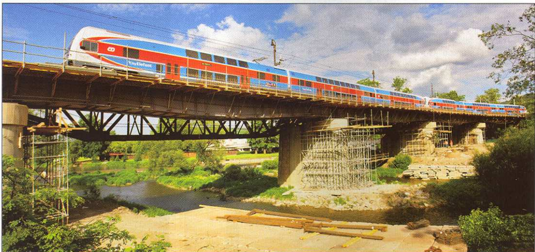
Vlak Os 2543 projíždí po staré části mostu, zatímco vedle probíhají práce na mostovce mostu nového. Směrem k fotoaparátu je vůz 451.093.
