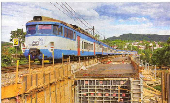
Vlak Os 2543 projíždí po staré části mostu, zatímco vedle probíhají práce na mostovce mostu nového. Směrem k fotoaparátu je vůz 451.093.
