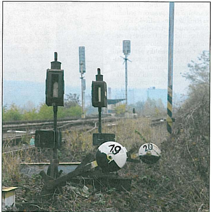
Návěstidla s kříží neplatnosti a rezivějící přestavníky či výhybková návěstidla jsou smutným obrázkem stanice Praha Modřany už od povodní v srpnu 2002. Modřany budou po dokončení obnovy zabezpečovacího zařízení nově dálkově řízeny výpravčím z Braníka, na zastávce se opět bude moci křížovat a i díky funkčním přejezdovým zabezpečovacím zařízením dojde ke zvýšení rychlosti.
